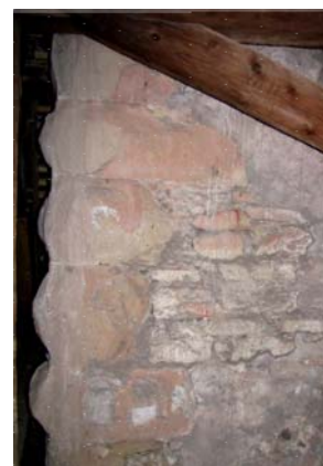
4) Detail původní bosované armatury věže (3B)
