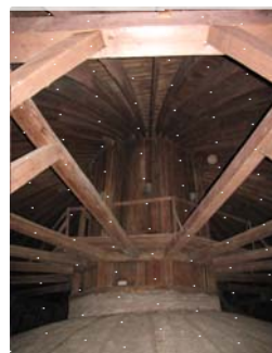
Dřevěná konstrukce krovu Rotundy
