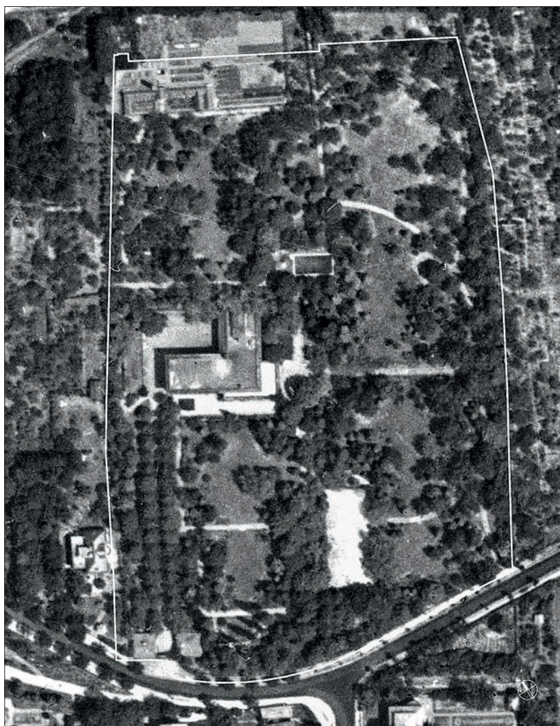
Obr. 26: Letecký snímek zahrady víly Stiasni v Brně z roku 1947 s definovanými hranicemi a základními objekty. Z leteckého snímku je dobře patrné celkové kompoziční řešení zahrady se stavebními objekty, terasami v okolí víly a celkové trasování cestní sítě. (Letecký snímek poskytl VGHMÚř Dobruška, © MO ČR 2015)
