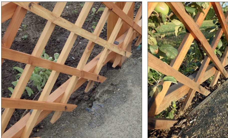
Obr. 11: Okraje mlatových cest vyvýšené nad terénem mohou být bez použití obrub nestabilní. Vlevo stav před dodatečnou instalací dřevěných obrub, vpravo po instalaci – Kolečná zahrada v Kroměříži. (Foto L. Křesadlová, 2014)
