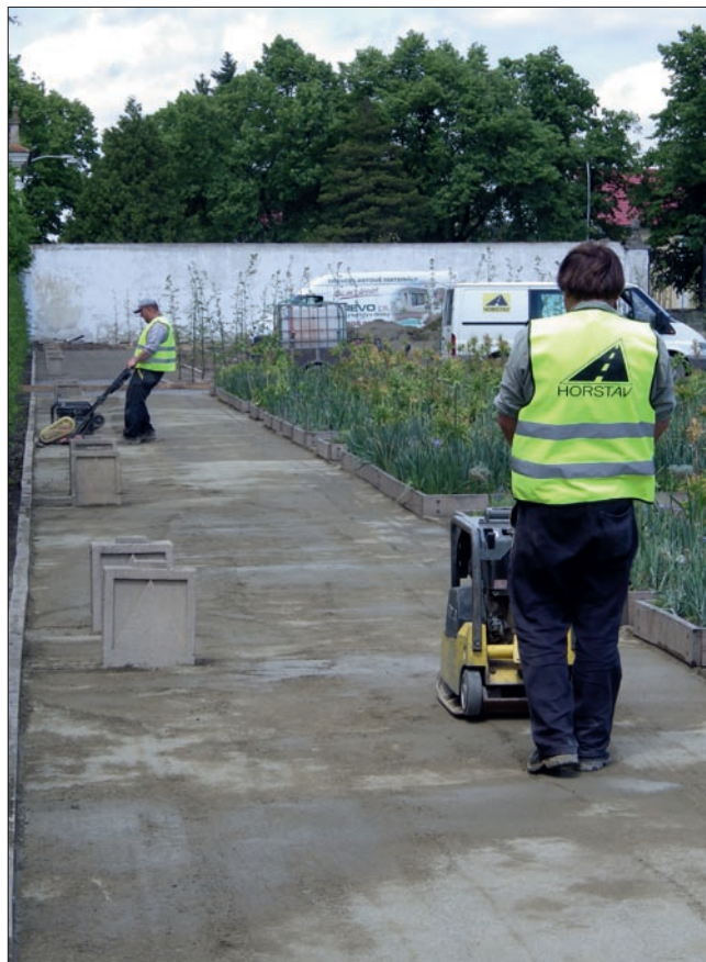
Obr. 21: Opakované vlhčení a hutnění s vrchní vrstvy patří k nejdůle- žitějším operacím při zakládání mlatových povrchů – Kočetná zahradka v Kroměříži. (Foto L. Křesadlová, 2014)
