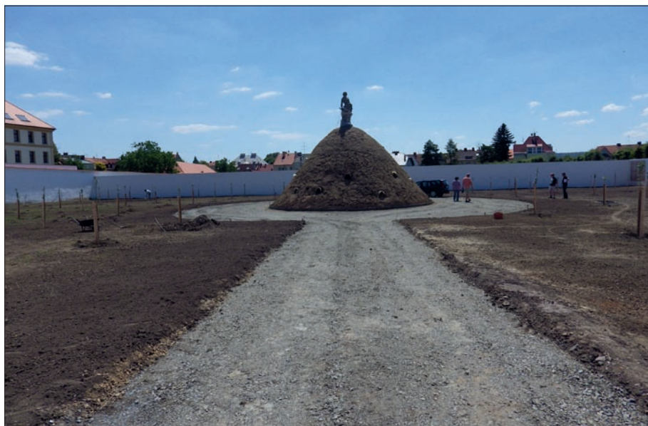
Obr. 19: Připravená podkladová vrstva pro nové založení mlátové cesty – Kuželná zahrada v Kroměříži. (Foto L. Křesadlová, 2014)
