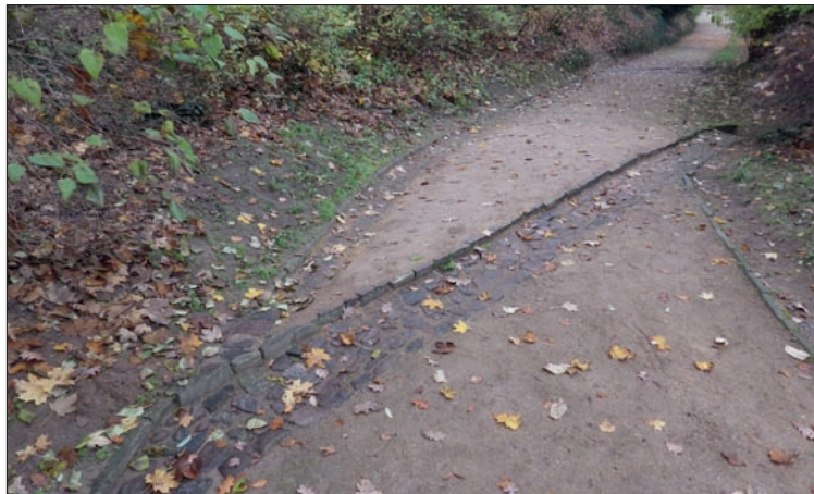
Obr. 15, 16: Různě typy příčného i podélného odvodnění cest ve svažitých partiích zahrad Sanssouci v Postupimi. (Foto L. Křesadlová, 2014)
