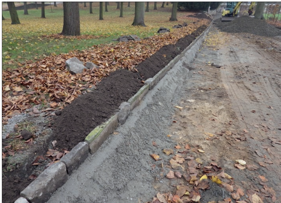
Obr. 12: Obruba z plochých kamenů upevněná do betonu – Sanssouci, Postupim (Foto L. Křesadlova, 2014).
