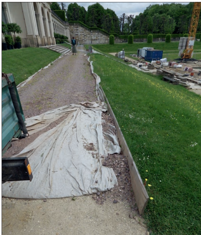
Obr. 22: Ochrana konstrukce mlatového chodníku při pojezdu těžší mechanizace v rámci rozsáhlé obnovy barokní zahrady Großsedlitz za pomoci textilie a vrstvy hrubého štěrku. (Foto L. Křesadlova, 2015)
