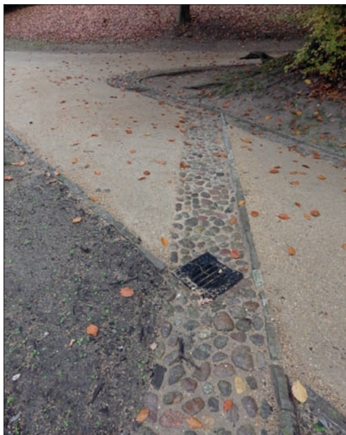
Obr. 15, 16: Různě typy příčného i podélného odvodnění cest ve svažitých partiích zahrad Sanssouci v Postupimi. (Foto L. Křesadlová, 2014)
