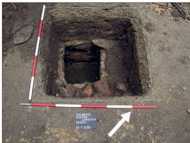
Obr. 17: Příčinou vzniku poruchy v cestě mezi Jahodovými kopečky v kroměřížské Kojetné zahradě bylo prolomení pískovcové desky překrývající reovizní otvor. (Foto J. Janál)
