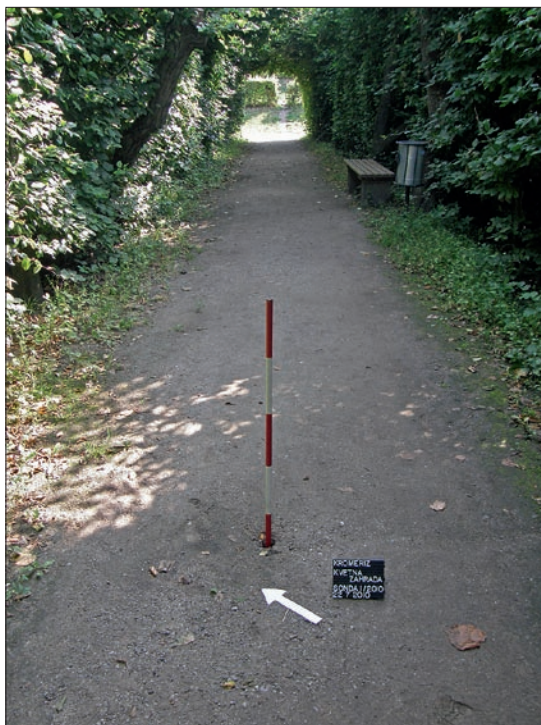
Obr. 16: Drobný otvor v cestě mezi Jahodovými kopečky v kroměřížské Kojetné zahradě indikuje poruchu v trase historického kanálu. Dvoumetrová trasírka dokazuje, že dno dutého prostoru se nachází 1,10 m pod úrovní cesty. (Foto J. Janál)
