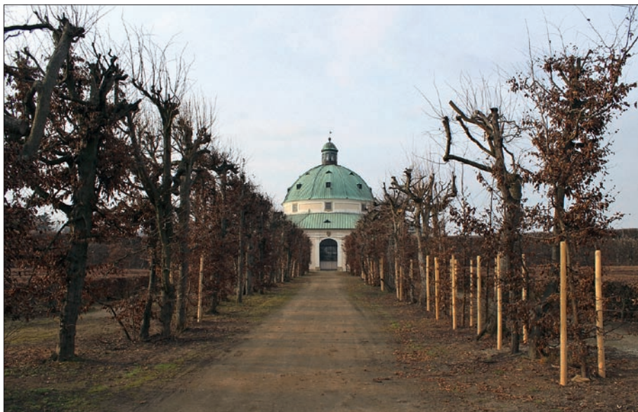
Obr. 10: Stěny na hlavní ose Květné zahrady v Kroměříži po provedení řezu a výsadeb (Foto L. Křesadlová, 2013)
