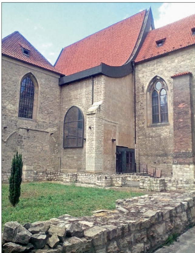
Obr. 24: Torzo původní zdi ambítu menších bratří v areálu kláštera so. Anežky České na Starém Městě v Praze před restaurátorskou obnovou zdiava, spojenou s doplněním vegetační vrstvy v koruně zdiava a výsevem travo-bylinné směsi. (Foto M. Straková, 2015)
