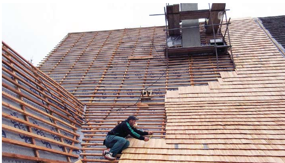
Vlastní montáž dřevěného štípaného šindele firmy. (Foto J. Polášek)
