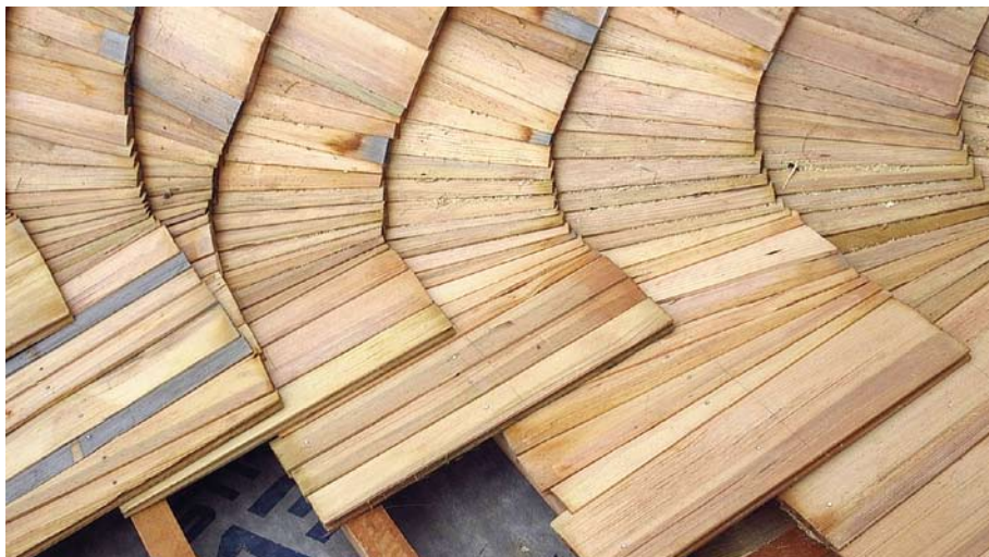
Odborné osazení úžlabin šindelů při montáži na střeše. (Foto J. Polášek)
