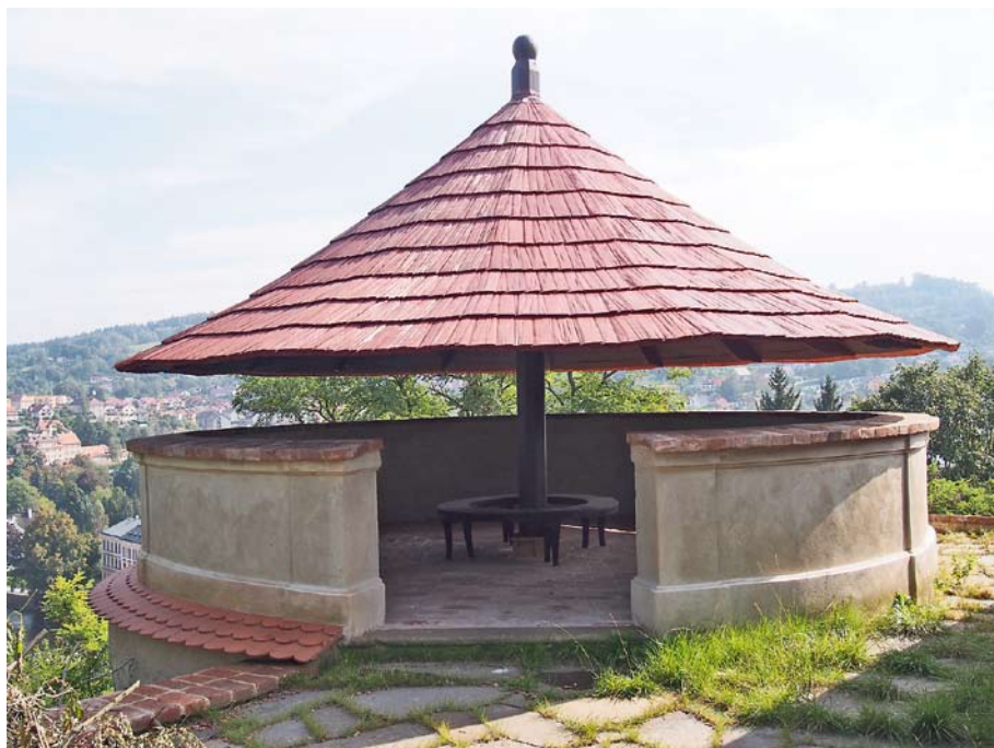
Vyhlídkový pavilon zvaný Paraplíčko v bývalé kuchyňské zahradě zámku v Českém Krumlově. (Foto L. Křesadlová, 2016)
