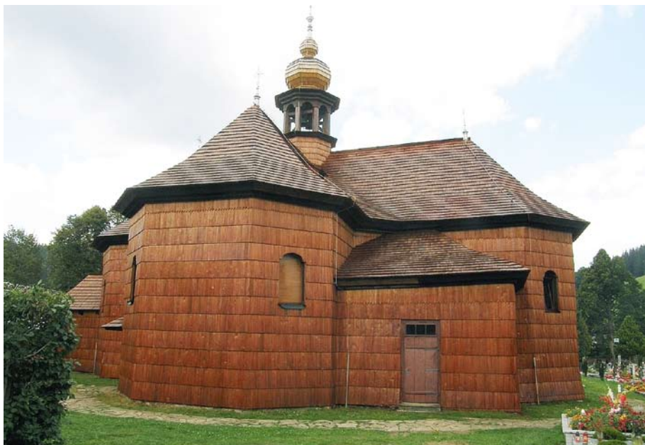
Velké Karlovice, kostel Panny Marie Sněžné, na roubených stěnách jedlový šindel na jednoduché krytí, na střeše jedlový šindel na dvojité krytí. (Foto J. Novosad, 2016)
