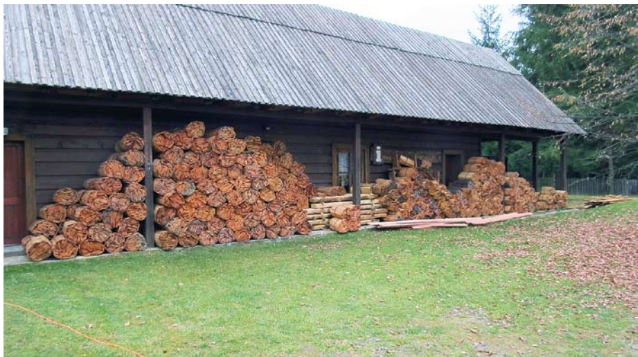
Způsob ukládky dřevěného štípaného šindele před vlastní montáží. (Foto J. Polášek)
