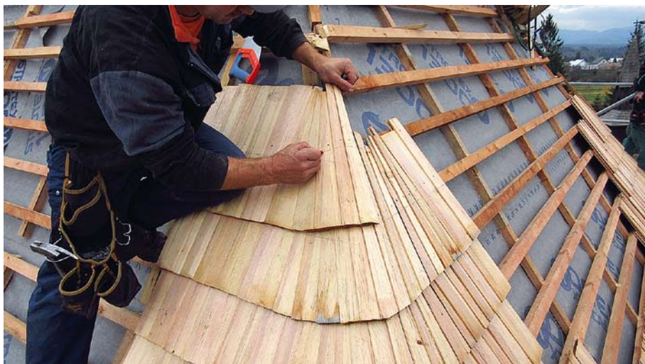
Odborné osazení rohových šindelů při montáži na střeše. (Foto J. Polášek)
