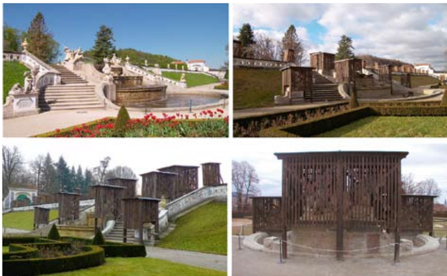
Obr. 83. Kolekce ilustračních snímků znázorňující ochranu sochařské výzdoby fontány v zimním období (foto P. Slavko).
