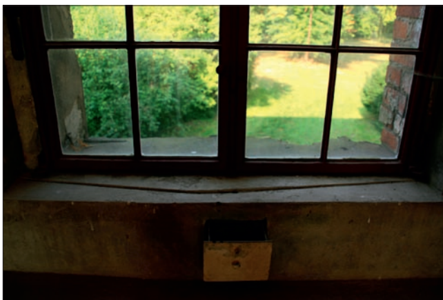
Obr. 42: Kanálek a nádoba na zachycení vody kondenzující na sklech ve Velké oranžerii v Sanssouci. (Foto J. Olšan, 2009)
