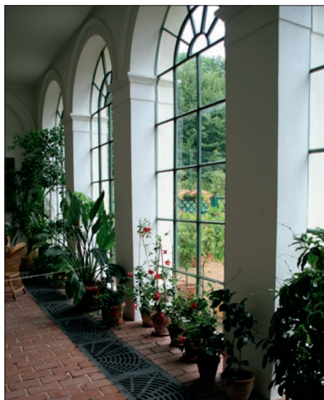
Obr. 33: Okrasná litinová mřížovina, kryjící kanálové topení – Raduň. (Foto J. Olšan, 2011)
