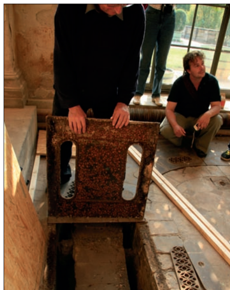
Obr. 32: Dvouplášťový horkovzdušný kanálový systém ve Velké oranžerii v Sanssouci. (Foto J. Olšan, 2009)
