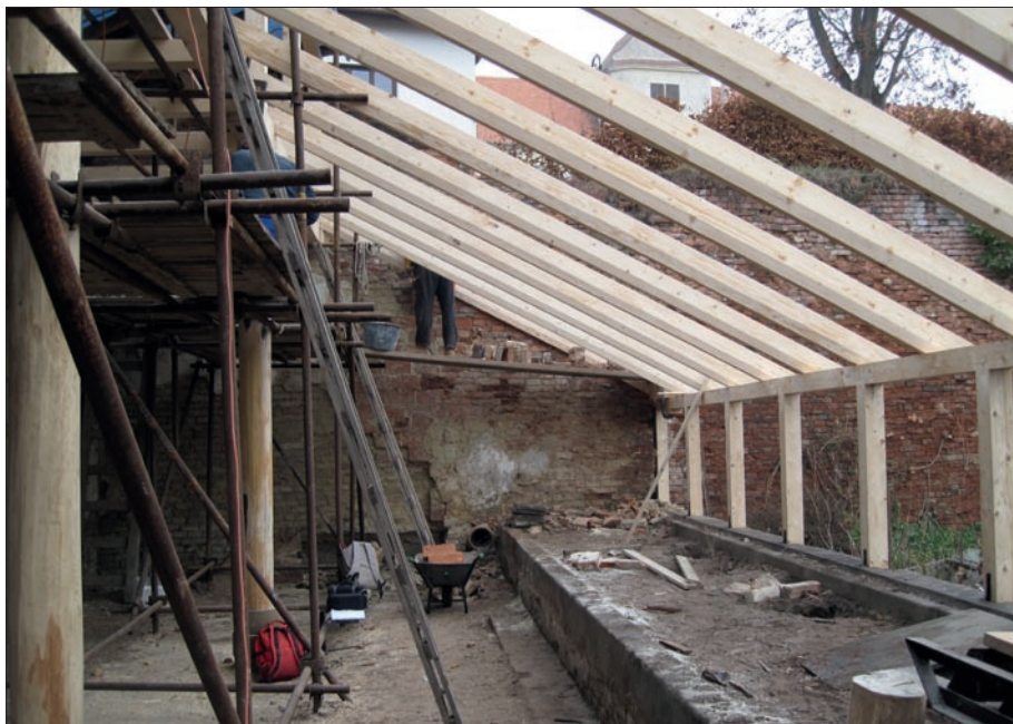
Obr. 55: Obnova čelní prosklené stěny. (Foto D. Fetterová, 2011)
