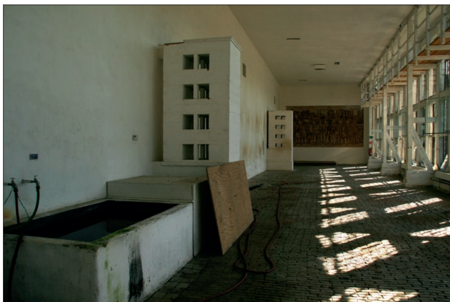
Obr. 30: Vytápění zděnými kamny s průduchy a nádrž na ohřev zálievkové vody v Oranienbaum. (Foto J. Olšan, 2009)
