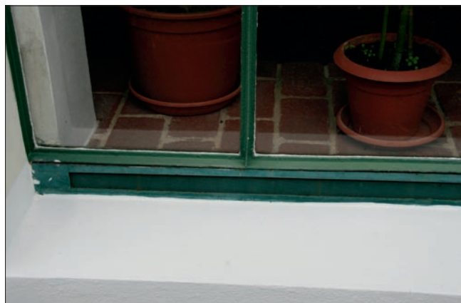
Obr. 35: Kovová mřížka pro nasávání chladnějšího vzduchu nad podlahou v oranžerii v Raduši. (Foto J. Olšan, 2011)
