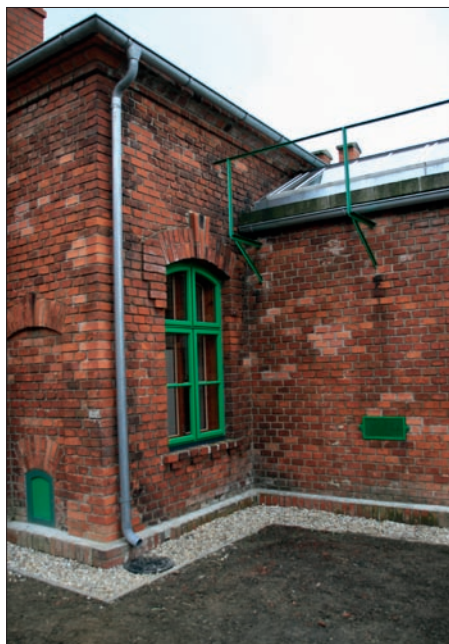
Obr. 38: V zadní stěně staoby se nacházejí příkladací dvířka topeniště a upravo mřížka větracího kanálku. Radkov – Dubová. (Foto J. Olšan, 2011)
