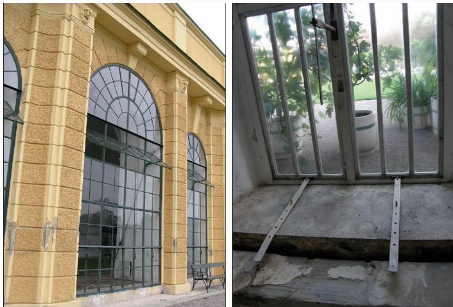
Obr. 40: Dva různé systémy otevírání oken – vyklápění oken pomocí převodů (vlevo), vyklápění pomocí děrovaných železných pásků (vpravo). (Foto L. Křesadlová, 2009)
