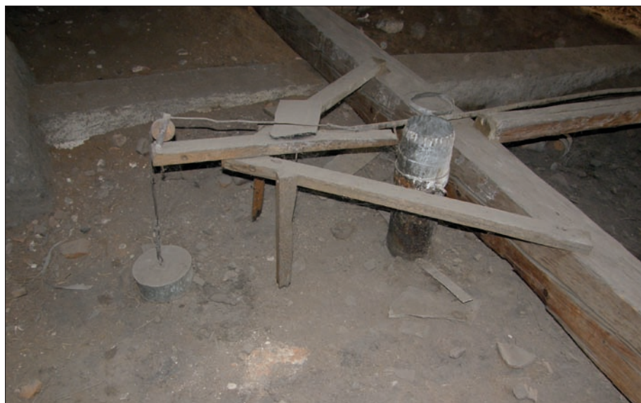
Obr. 41: Mechanismus regulace stropního ventilačního systému ve Velkém skleníku v Kočtné zahradě v Kroměříži. (Foto J. Janál, 2013)
