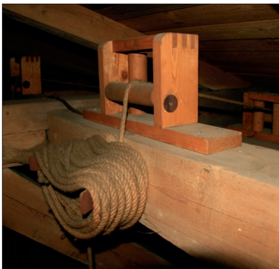
Obr. 36: Svinovací izolační rákosová rohož a její mechanismus navíjení umístěný na půdě oranžerie v Lysicích. (Foto E. Choosta, 2011).
