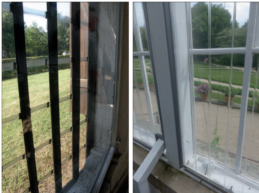
Obr. 45: Možnosti zlepšení tepelně izolačních vlastností prosklených částí skleníku vložením novodobé konstrukce za původní okna stavby. (Foto L. Křesadlová, 2009)
