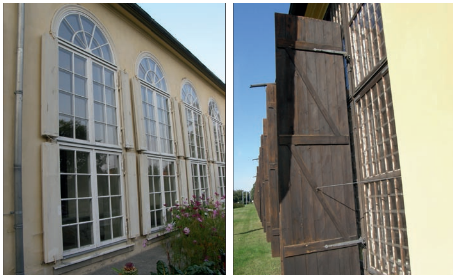
Obr. 34: Okenice pro omezení úniku teploty v nočních hodinách v Sanssouci a Oranienbaum. (Foto L. Křesadlova, 2009)
