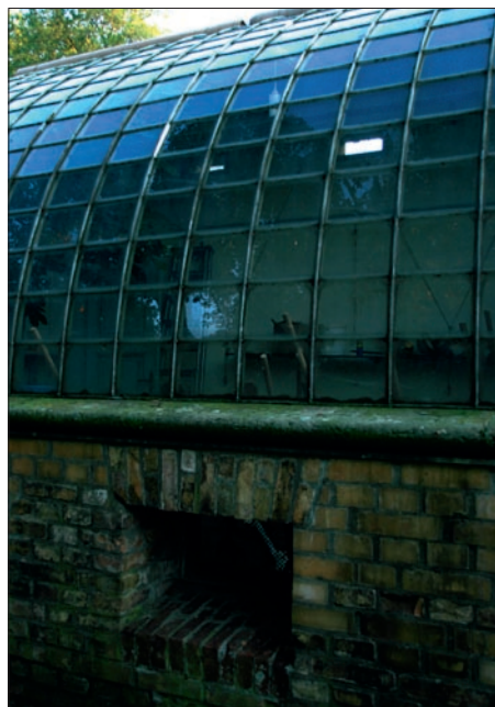
Obr. 39: Otvor v podezdívce slouží k nasávání chladnějšího vzduchu v Neue Glienicke. (Foto J. Olšan, 2009)
