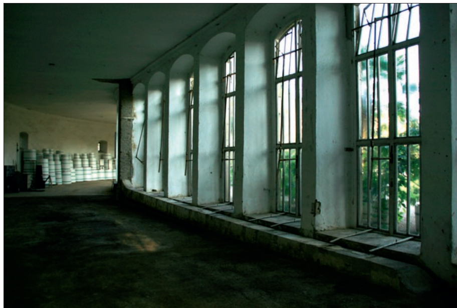
Obr. 31: Pozvolná stoupající zděný spalinový kanál, výjimečně se vstupem do komína na přední stěně v oranžerii Wiemar – Belvedere. (Foto J. Olšan, 2009)
