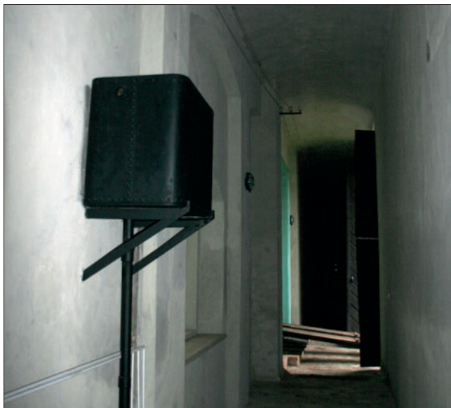
Obr. 46: Již nefunkční expanzní nádoba pro teplovodní kanálové topení byla zachována spolu se starými rozvody el. energie jako zajímavý doplněk interiéru obslužné chodby Palmového skleníků Kočetné zahrady v Kroměříži. (Foto J. Olšan, 2014)
