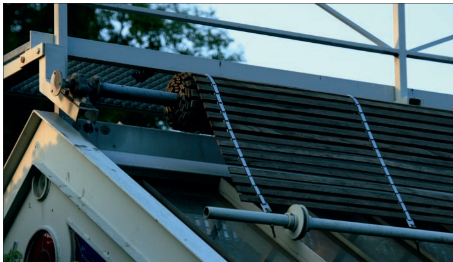
Obr. 37: Vnější stínící lamelová roleta. Posun zajišťuje klíka pohánějící hřídel – Wiemar – Belvedere. (Foto J. Olšan 2009)
