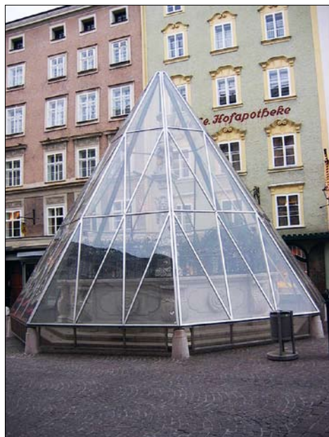
Obr. 66: Salzburg, Rakousko – kašna svatého Floriana na náměstí Alte Markt pod ochrannou konstrukcí z plexiskla. ( www.bda.at/text/136/908/10076/Florianibrunnen-am-Alten-Markt-in-Salzburg-restauriert )
