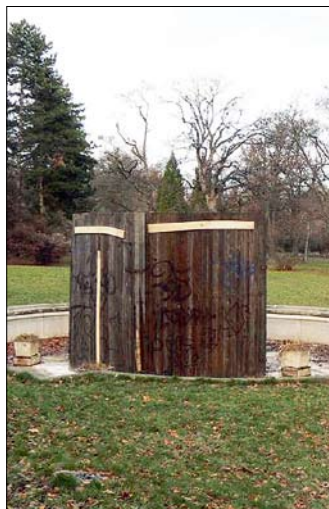
Obr. 57: Brno, park Lužánky – systém zimní ochrany fontány se sousoším, stav před montáží a po montáži ochranné konstrukce. (Foto L. Křesadlová, 2016)
