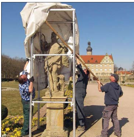
Obr. 61: Weikersheim, Německo – příklad použití zimních krytů v podobě stanů pro ochranu soch v zámecké zahradě. ( http://www.schloss-weikersheim.de/wissenswert-amuesant/dossiers/einhausen-der-sandsteinfiguren/ )
