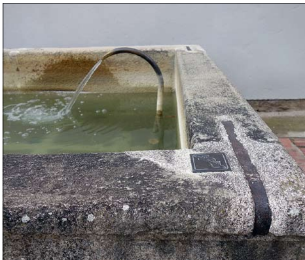
Obr. 51: Český Krumlov, 5. nádvoří zámku – kašna je provozována s uzavřeným oběhem vody, voda v systému kašny je chemicky ošetřena. Návštěvníci jsou informováni piktoqramem, že voda není pitná. (Foto J. Olšan, 2016)
