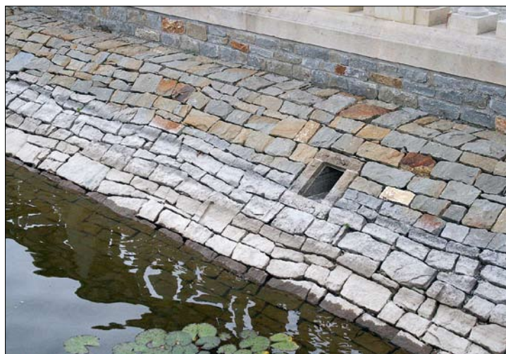
Obr. 89: Skimmer skrytý v konstrukci břehu východního Pstružího rybníka. (Foto, J. Obšiváč, 2016)
