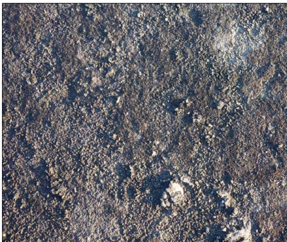
Obr. 26: Povrch desky z mušlového vápence degradovaný působením kyselých dešťů, vymýváním vápencového pojiva došlo k vydrolení menších zrn, větší a odolnější úlomky křemene a žilců v kameni zůstávají, úbytek povrchu činí v průměru až 0,5 cm. (Foto J. Olšan, 2016)
