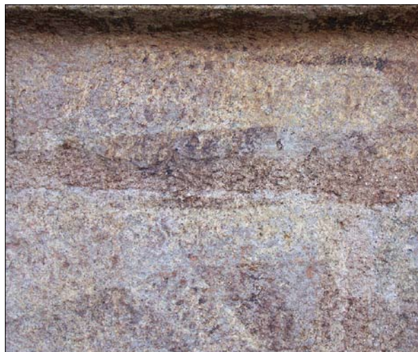
Obr. 41: Povrch kamenného obkladu stěny vodního proku po nevhodně provedeném mytí tlakovou vodou. Nerovnoměrná barevnost povrchu svědčí o tom, že při mytí se nacházela tryska vysokotlakého čističe příliš blízko omývané stěně. Výsledkem neodborného postupu obsluhy čističe je jednak nestejnoměrně umytý povrch konstrukce vodního proku, ale pravděpodobně také degradace jejího povrchu příliš vysokým tlakem dopadající vody. (Foto J. Olšan, 2016)
