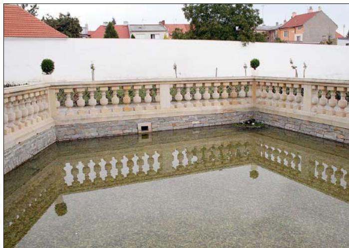
Obr. 91: Hladina bazénu u Ptácnice s ústím skimmeru. (Foto J. Obšivač, 2016)
