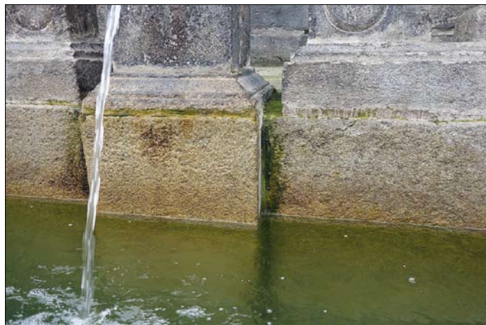
Obr. 28: Napadení povrchu kamene zkrápěného vodou řasami. (Foto J. Olšan, 2016)
