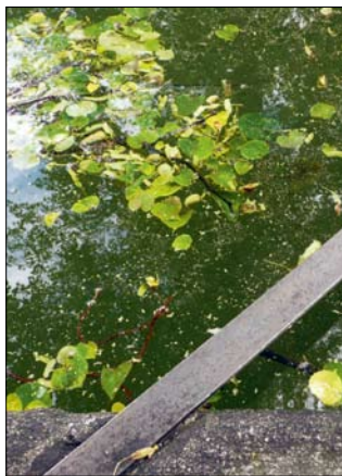
Obr. 46: Český Krumlov, kašna v parcíku na 1. nádvoří zámku – fotografie ukazují znečištění vody růstem řas a opadem listů ze stromů rostoucích v okolí kašny. (Foto J. Olšan, 2016)
