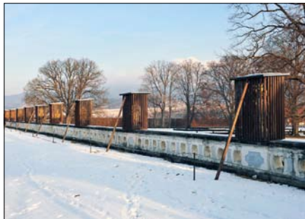
Obr. 54: Český Krumlov – zkouška prototypu zimního krytu kamenných dekorativních váz na balustrádě u Kaskádové fontány, zimní aspekt balustrády po osazení celého souboru ochranných krytů. (Foto P. Slavko, 2005, 2011)
