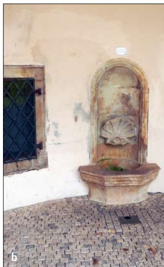
Obr. 22: Brno – pramen zdraví: a – vlevo od nadzemního objektu je patrný vstupní poklop do podzemní strojovny, b – voda do prameníku se pouští pomocí nášlapné armatury v podlaze. (Foto Z. Žabička, 2012)
