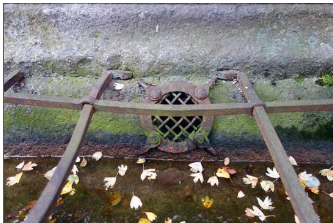
Obr. 37: Povrch železných dílů dlouhodobě neprovozované kašny degradovaný atmosférickou korozí. (Foto J. Olšan, 2016)
