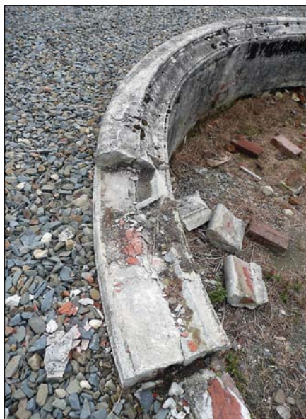
Obr. 34: Štáblovice u Opavy – detail rozpadu konstrukce profilované koruny z umělého kamene a detail cihelného zdiva stěny bazénu fontány, poškozeného vlhkostí a krystalizací solí z cementového potěru. (Foto E. Olšanová, 2014)
