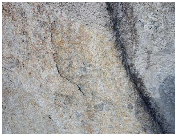
Obr. 40: Detail degradovaného povrchu obkladové desky stěny fontány z krystalického vápence. Konstrukce vodních proků z přírodního kamene, jejichž povrch je degradován, není možné omývat tlakovou vodou. (foto J. Olšan, 2016)
