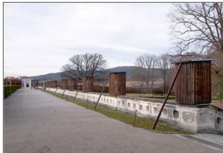
Obr. 54: Český Krumlov – zkouška prototypu zimního krytu kamenných dekorativních váz na balustrádě u Kaskádové fontány, zimní aspekt balustrády po osazení celého souboru ochranných krytů. (Foto P. Slavko, 2005, 2011)
