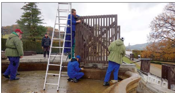
Obr. 119: Montáž zimního krytu sousoší Nereidky se Silénem. (Foto J. Olšan, 2016)
