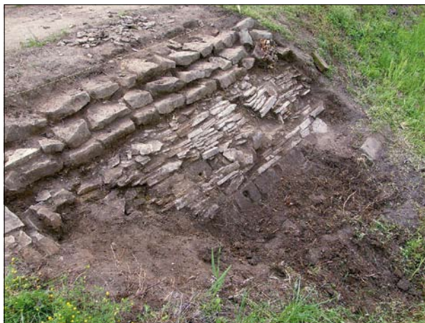
Obr. 86: Původní barokní konstrukce západního Pstružího rybníka odkrytá při archeologickém výzkumu. (Foto J. Janál, 2009)
